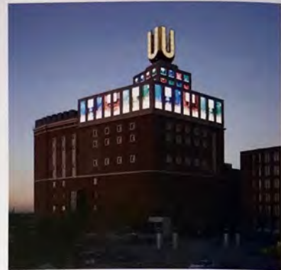
▲ Das Dortmunder U, ein ehemaliger Brauerei-Kühlturm, hat sich in wenigen Jahren zu einem Dortmunder Wahrzeichen gemauert, das derzeit unter anderem das kiU beherbergt. Foto: Hans-Jürgen Landes
