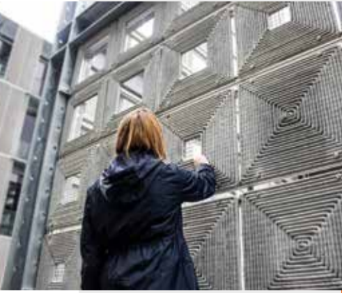
Beton-gedruckte Fassadenelemente am Forschungsbau „x.Stahl“ Foto: Michael Braun
