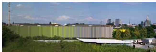
Abb 2-2 Die Farbgebung einer Halle beeinflusst die energetische Effizienz der solarthermischen Komponenten.
