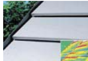
Abb. 2.4: „Quick-step“, unverglaster Sonnenkollektor der Fa. Rheinzink
