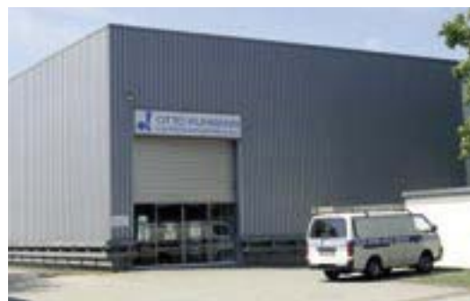
Abb. 1.2: Ansicht einer typischen Gewerbehalle mit metallischer Hülle aus Trapezprofilen
