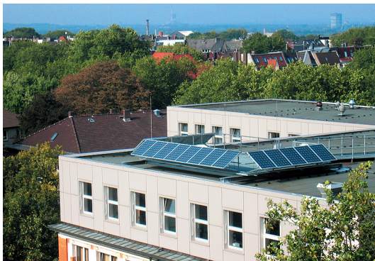
Abb. 4. PV-Generator mit Ost-, West- und Süd-Ausrichtung
