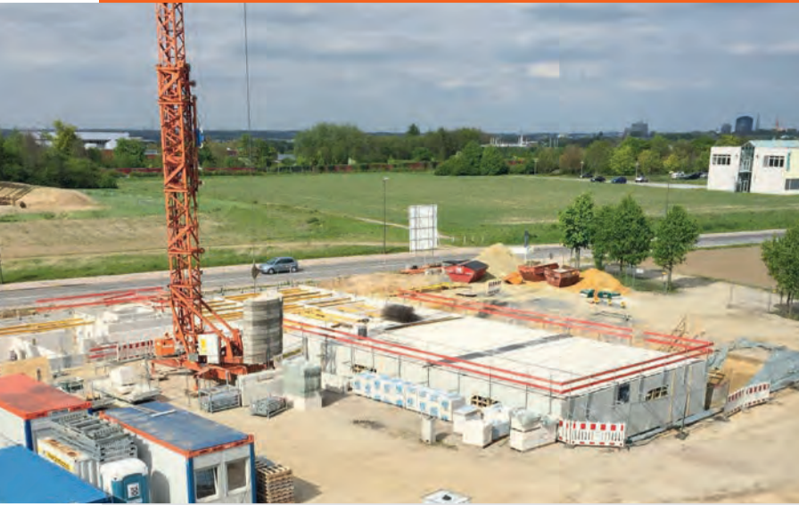
Das „FH Plus 3“-Gebäude auf dem Campus: Der Rohbau wächst zügig.
