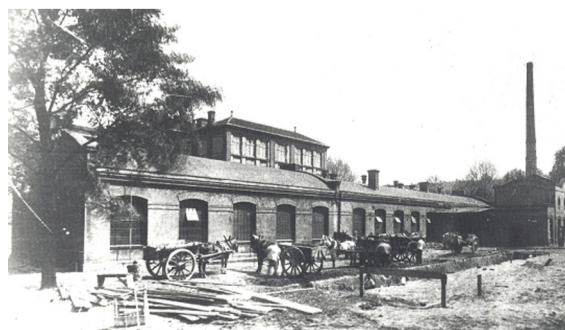
Blick vom Neuen Graben auf das alte Maschinenhaus (1897 - 1929)
