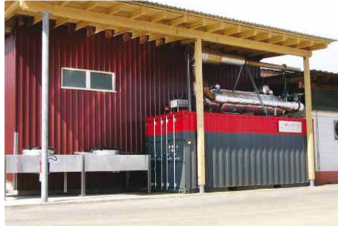
Prototyp für 30 kWel. Die Anlage arbeitet seit 2009, wurde in 2010 und 2011 optimiert und läuft seit Mitte 2011 durchgängig mit 25 bis 27 kWel.
